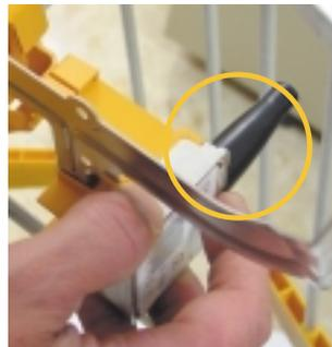
Cappuccio in gomma per rendere impermeabile la connessione
